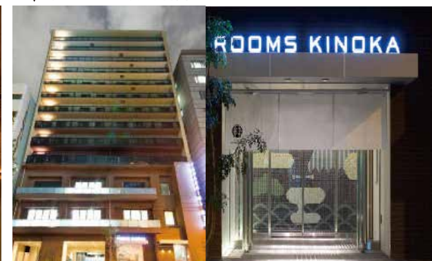
▼集合住宅 外観照明計画
